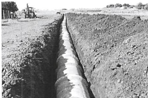
Figura 4. Instalação de galeria
